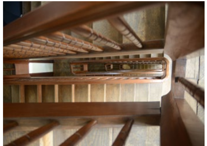
Gedrechselte Geländer in den Treppenaufgängen
