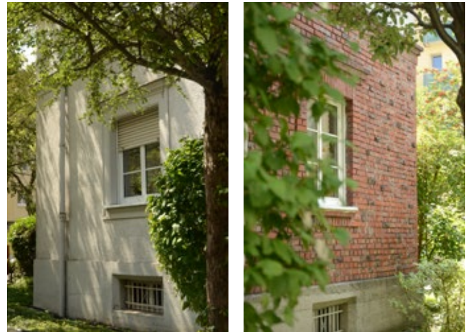
Putzoberflächen und Klinkersteine
