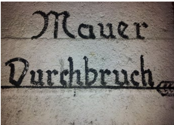
Mauerdurchbruch im Luftschutzkeller
